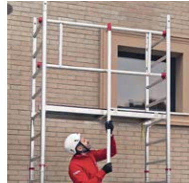
Nuovo sistema di montaggio in sicurezza dei parapetti. New safe assembly system of the guard-rails frames.
