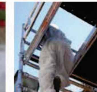
Die Plattformen aus rutschfestem Holz und die Verwendung der Klappen sind ein Sicherheits-Muß bei Arbeiten in der Höhe.
