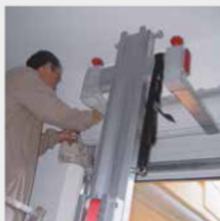
Montaggio di tapparelle. Installing shutters.
