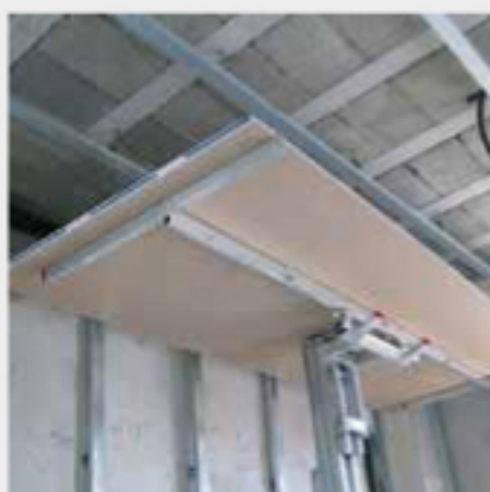
Montaggio di pannelli in cartongesso. Installing plasterboard panels.
