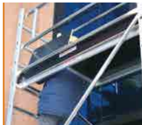
Bei Verwendung der Klappe kann in Sicherheit aufgestiegen werden. Grâce à l'utilisation de la trappe, on monte en toute sécurité.
