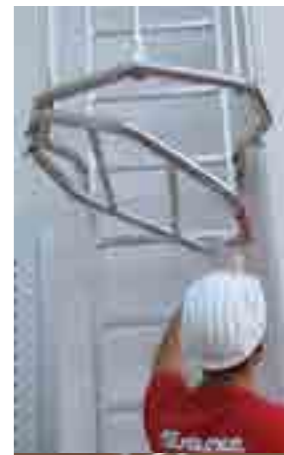
Die Klappe garantiert dem Benutzer der Leiter Sicherheit, schützt aber auch vor unbefugtem Betreten: passive Sicherheit.
