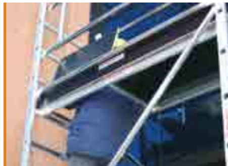
Bei Verwendung der Klappe kann in Sicherheit aufgestiegen werden. Grâce à l'utilisation de la trappe, on monte en toute sécurité.
