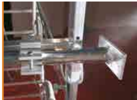
Wandverankerung. Étrier pour ancrage au mur.
